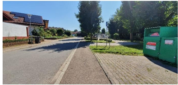
Hinterdörfer Weg (Blick von Nordwesten)
