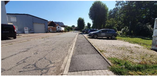
Hinterdörfer Weg (Blick von Nordwesten)
