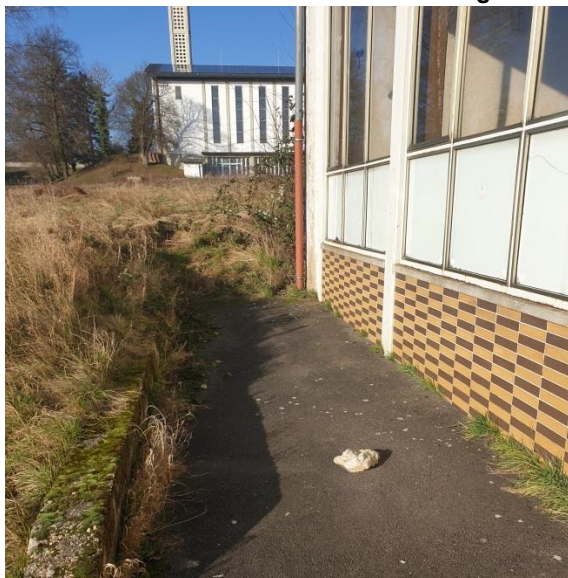
Habitatstrukturen um die Sporthalle sowie an den Geltungsbereich angrenzende Kirche
