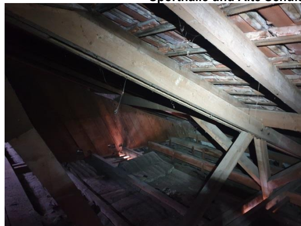
Dachstuhl der Sporthalle
